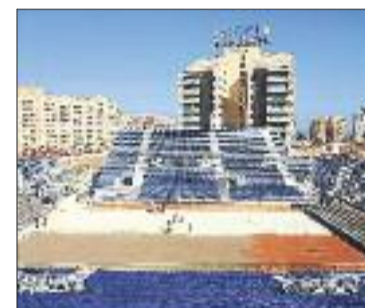
Construcción de la pista.
