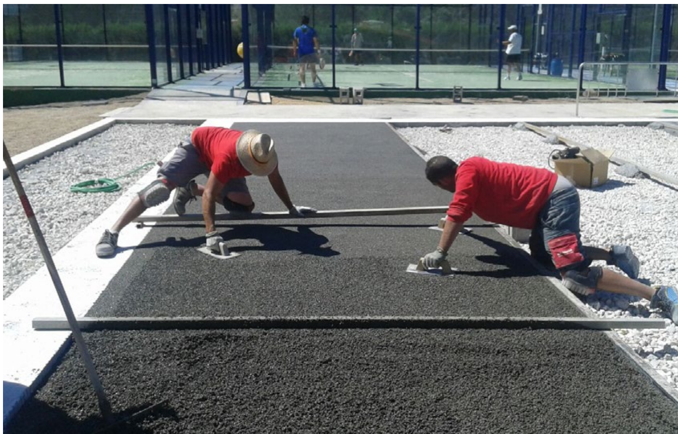
Realización de solera de hormigón poroso.
