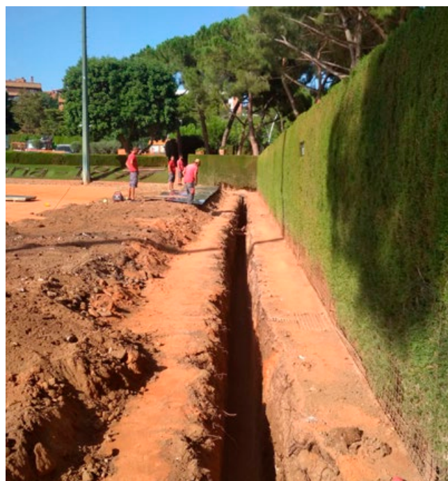
Construcción muro antirraíces RCT Barcelona.
