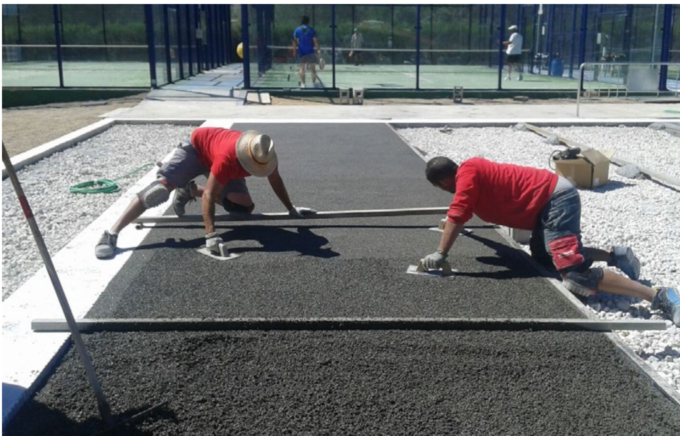
Realización de solera de hormigón poroso.
